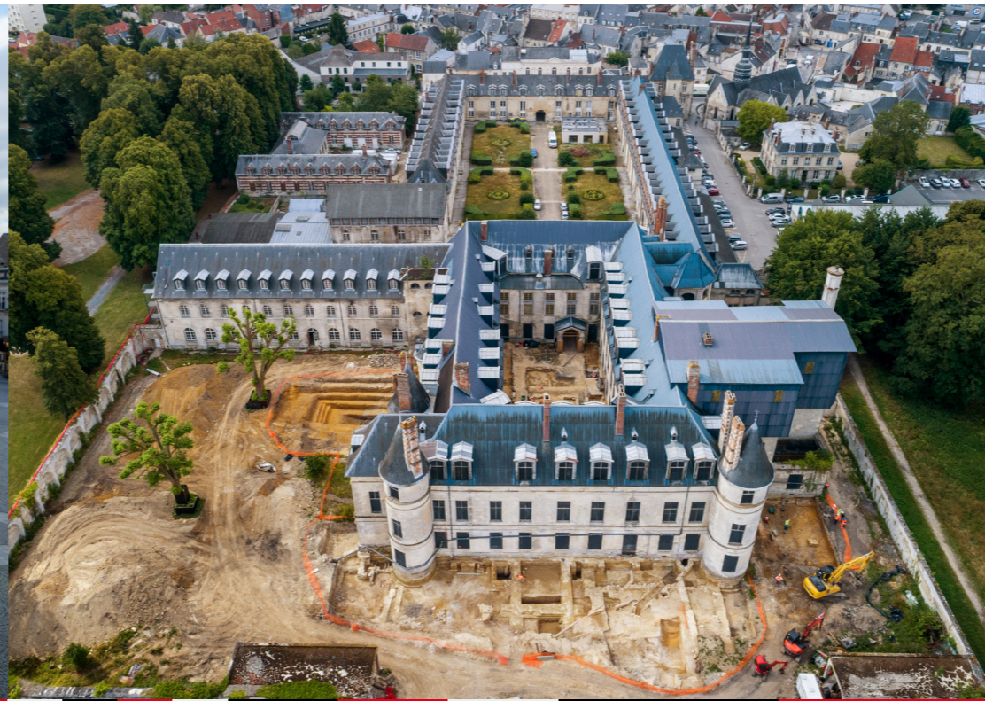
Chantier de fouille au château de Villers-Cotterêts (Aisne)
